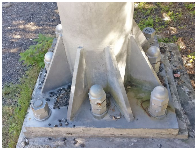
Bild 2 Schwerlastanker mit Kopfbolzen
